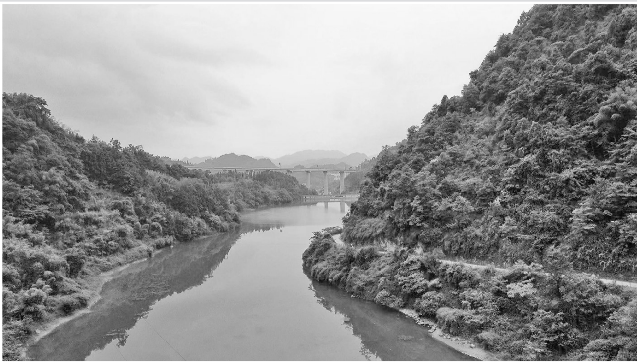
盐津县盐井镇水田坝新区油房沟水库一瞥。
